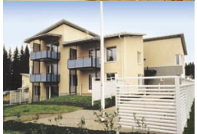
30, 31 (onder). Geprefabriceerde staalframebouw elementen combineren een hoge bouwsnelheid met een laag gewicht.
