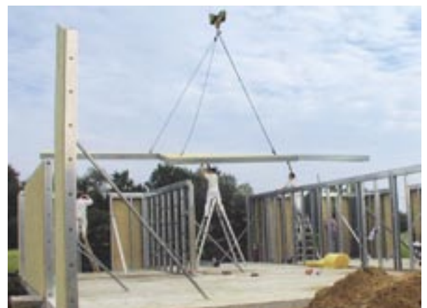
43. Montage van een prefab staalframebouw vloerelement (SwitchHaus, Bopfingen).
