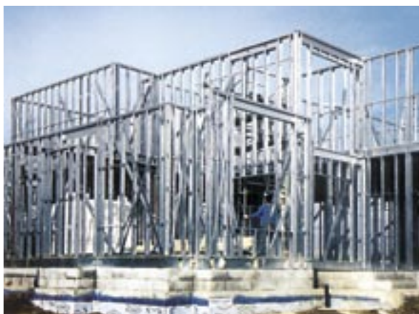
42. Assemblage van een staalframebouw woning op de bouwplaats (Armor Steel Framing Systems, Canada).
