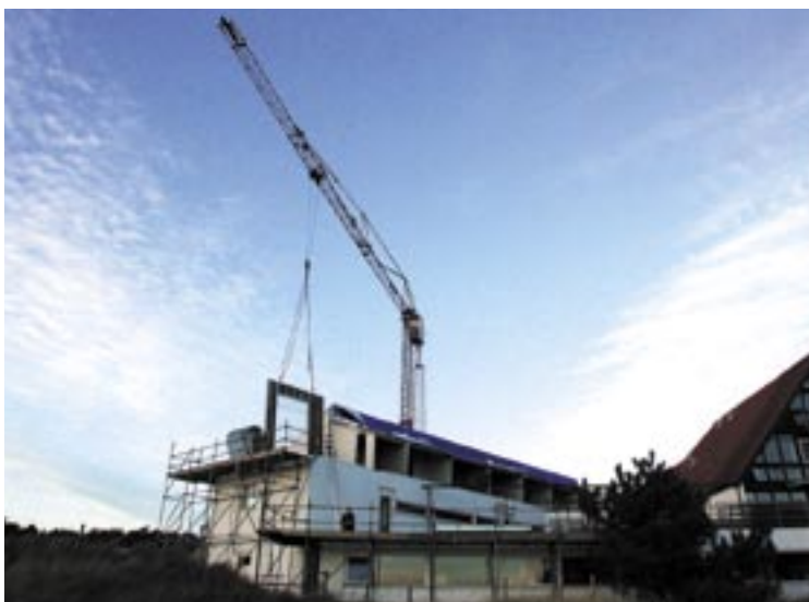
8. Optop jongerenhostel Stayokay (Terschelling, 2001). Vanwege het lage toelaatbare gewicht kon deze uitbreiding uitsluitend met staalframebouw.
