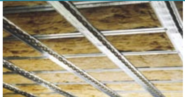
56. Geluidsarme veerregels als akoestische ontkoppelde bevestiging van het plafond aan de vloer (Profilhaus, Ettlingen).
