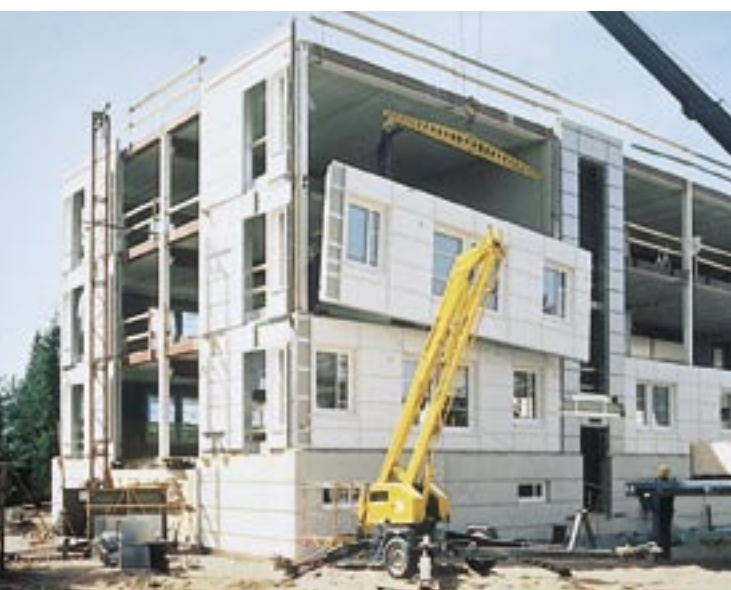
47. Montage van geprefabriceerde elementen (Rautaruukki Oyj, Finland).
