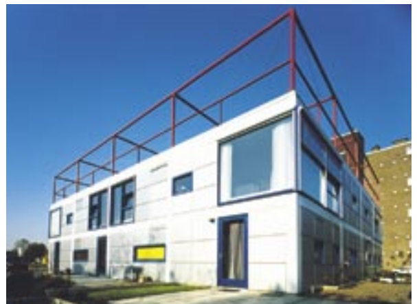
17. Woningen met een hoofddragconstructie van staalframebouw (Dedemsvaartweg, Den Haag).
