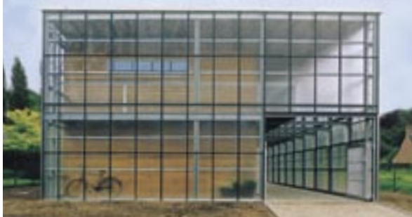
5, 6, 7. Gebouwen van staalframebouw met de staalconstructie in het zicht (Sadef, België).
