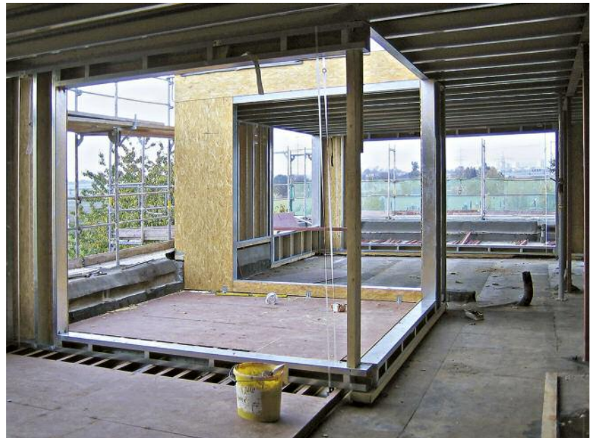
Montage der Wand- und Dachelemente als Halbfertigteile vor dem Schließen der Konstruktion mit innenliegender Beplankung im Zuge des Ausbaus
