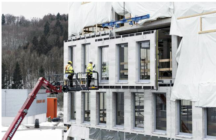
Elementbau: Die komplett vorgefertigte Stahl-Leichtbau-Fassade eines Verwaltungsgebäudes in Grafenau reduziert die Lasten der Konstruktion und beschleunigt den Baufortschritt – auch im Winter.
