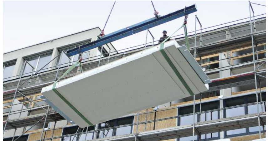
Montage der vorgefertigten Stahl-Leichtbau-Elemente
