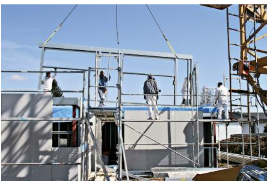
Kranmontage von auf der Baustelle vorgefertigten Rahmen
