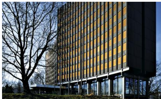
Die elfstöckige Hochhaus-scheibe vor der Sanierung
