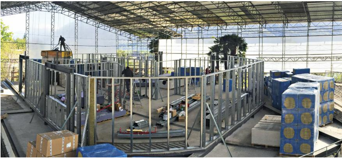
Baustellenfertigung: Aufstockung und thermische Sanierung einer einstöckigen Villa aus den 1960er Jahren in Ascona (CH) unter temporärem Witterungsschutz
