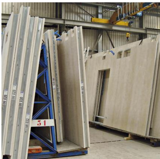
Elementbau: vorgefertigte Wandelemente (links) und deren Montage (rechts) für die zweigeschossige Aufstockung auf dem Bestandsgebäude der Klinik Lengg (CH)
