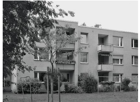
Bestandsgebäude vor der Sanierung
