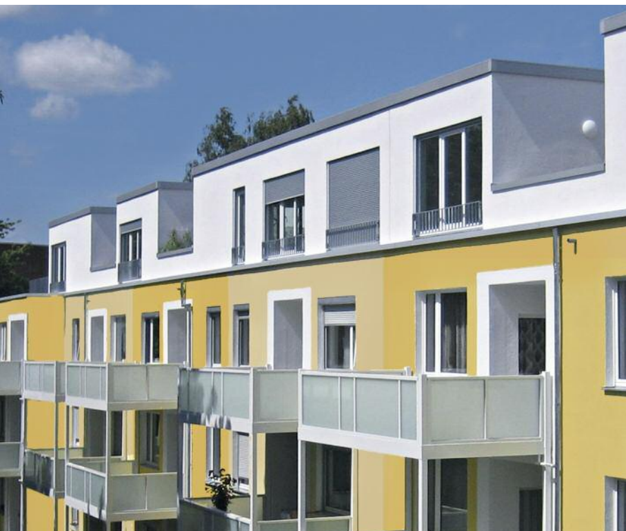
Gartenansicht nach der Sanierung mit eingeschossiger Aufstockung
