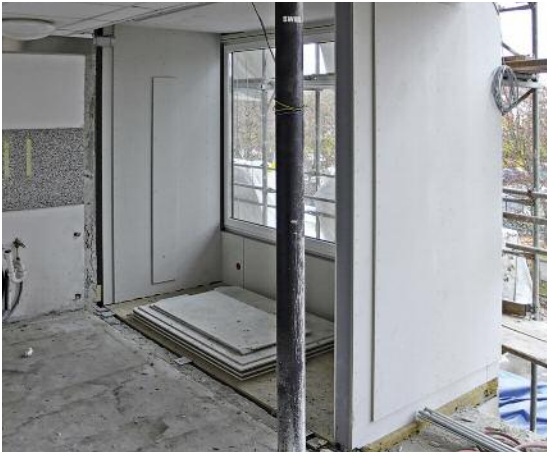
Vergrößerung der Studen- tenzimmer durch die vor- gehängte Stahl- und Stahl- Leichtbau-Konstruktion
