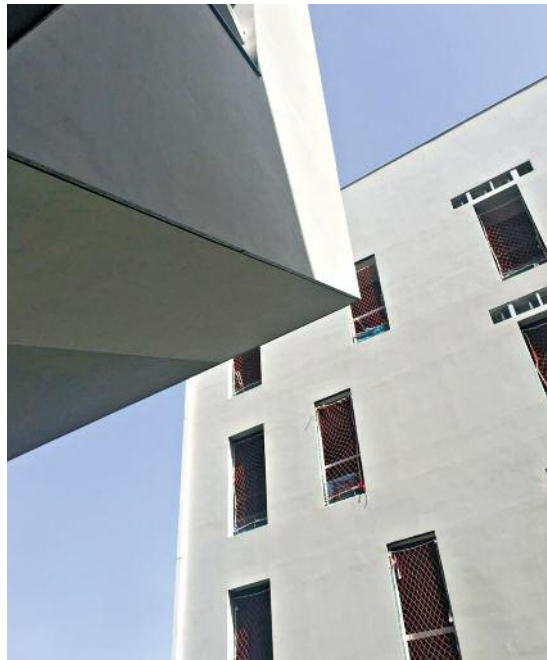
Innenhof-Fassade mit gespachtelten Leichtbeton-Bauplatten in der Bauphase
