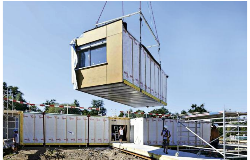
Modulbau: Vorfertigung (links) und Montage (rechts) der komplett ausgestatteten Raumzellen in Stahl-Leichtbauweise für das Alterszentrum Lenzburg (CH)
