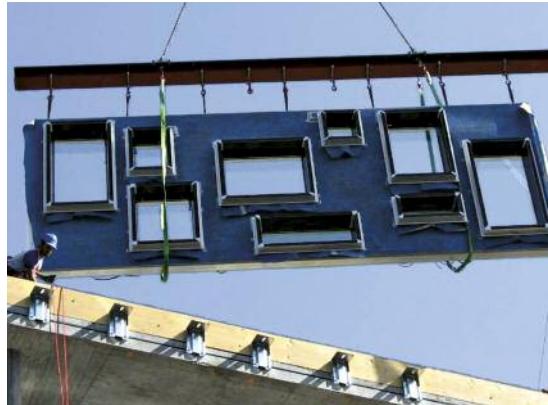
Produktionsstraße zur Fließbandfertigung der Fassadenelemente (links), Montage eines Fassadenelementes (rechts)
