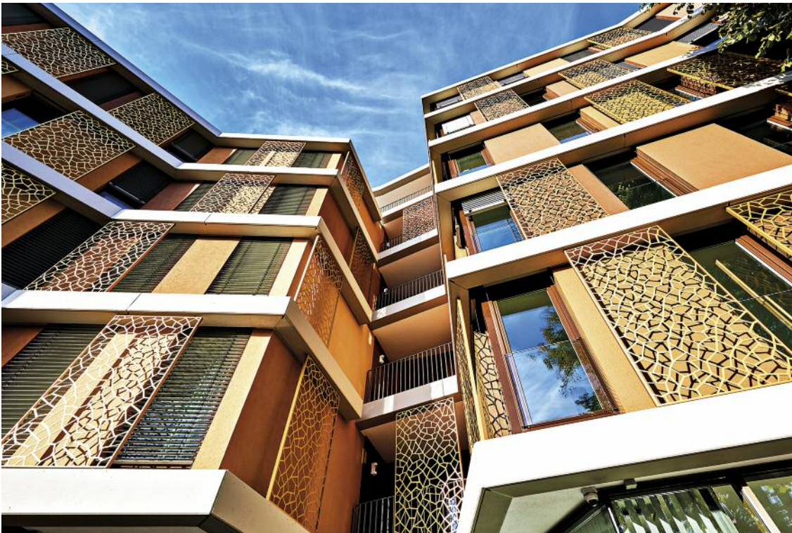
Außenwand/Fassade: Wohnanlage Vauban V6 in Freiburg. In den Stahlbeton-Skelettbau ist eine zweischalige Außenwandkonstruktion in Trockenbauweise mit integrierter Lüftungs- und Klimatechnologie eingestellt.
