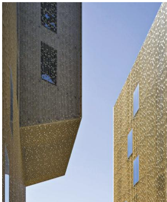
Vor die Stahl-Leichtbau-Fassade der Gebäudeeinschnitte wurde ein filigranes Gitterwerk aus eloxierten Metallprofilen montiert.
