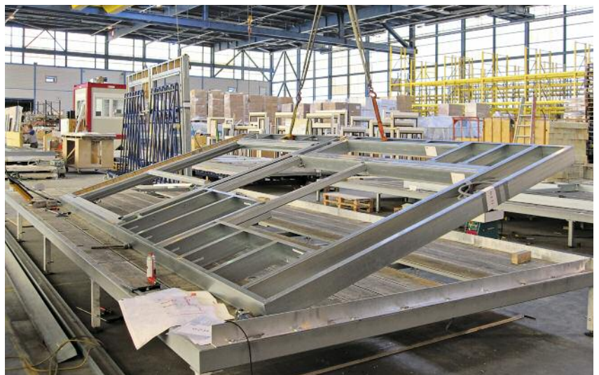
Vorfertigung von Außenwandelementen
