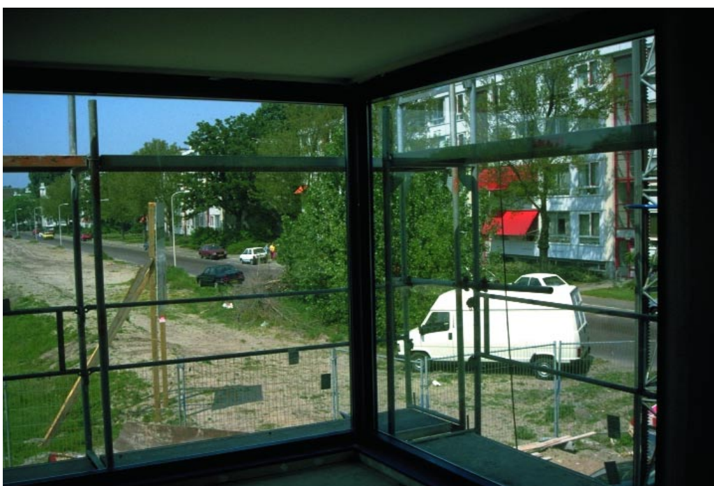
afb. 5.25 Transparante hoekoplossing in staalframebouw aan de Dedemsvaartweg in Den Haag.
