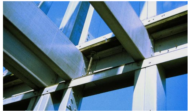
afb. 5.28 Uitvoering stabiliteitsverband en aansluiting strip.
