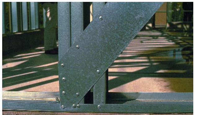
afb. 5.29 Stabiliteitsverband van brede strip.
